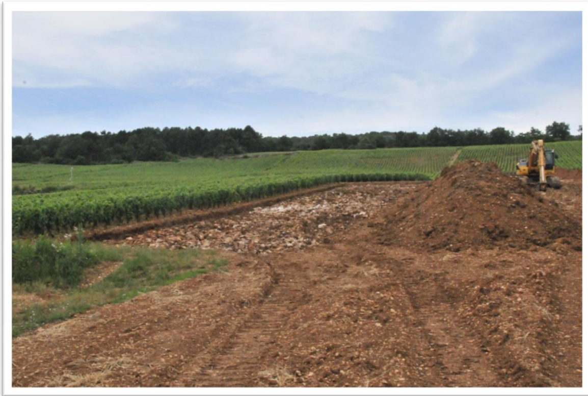
Openbreken harde kalklagen in ondergrond. Wijngaard Les Folatières, Premier cru Puligny-Montrachet, Bourgogne, 24 juni 2012.
